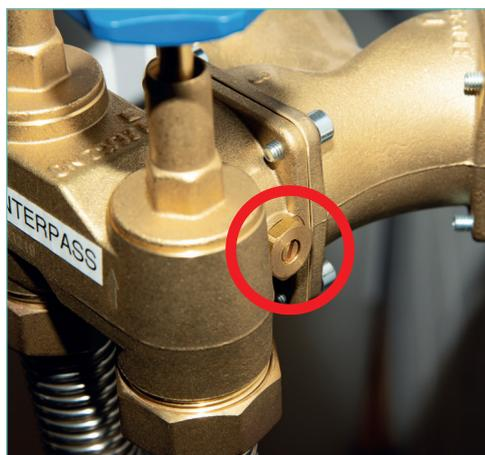
Si vous voulez ajuster la dureté de l'eau, vous pouvez le faire avec cette vis. Tournez la vis dans le sens inverse des aiguilles d'une montre pour rendre l'eau plus dure. Tournez-la dans le sens des aiguilles d'une montre pour rendre l'eau plus douce. Ne la tournez que très légèrement, puis faites couler l'eau pendant environ 3 min et mesurez la dureté de l'eau. Répétez ensuite le processus jusqu'à ce que vous obteniez la dureté souhaitée.
